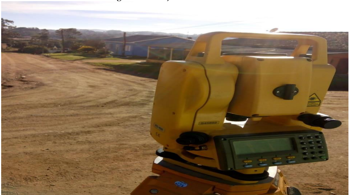
Figura 5: Estação total ao fundo via em estudo.
