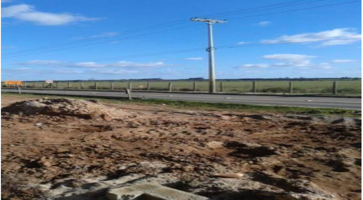
Figura 5: Alargamento da Rodovia.
