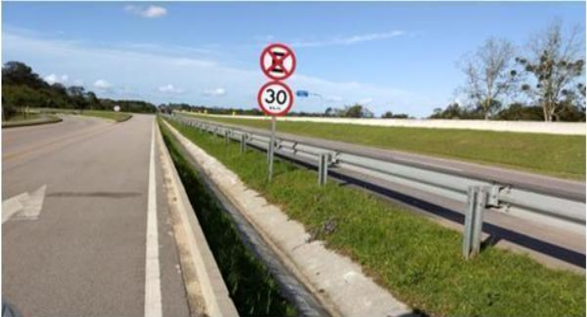
Figura 3: Ponte sobre o Arroio Pelotas e Defensas na BR 116, Km 511,6.
