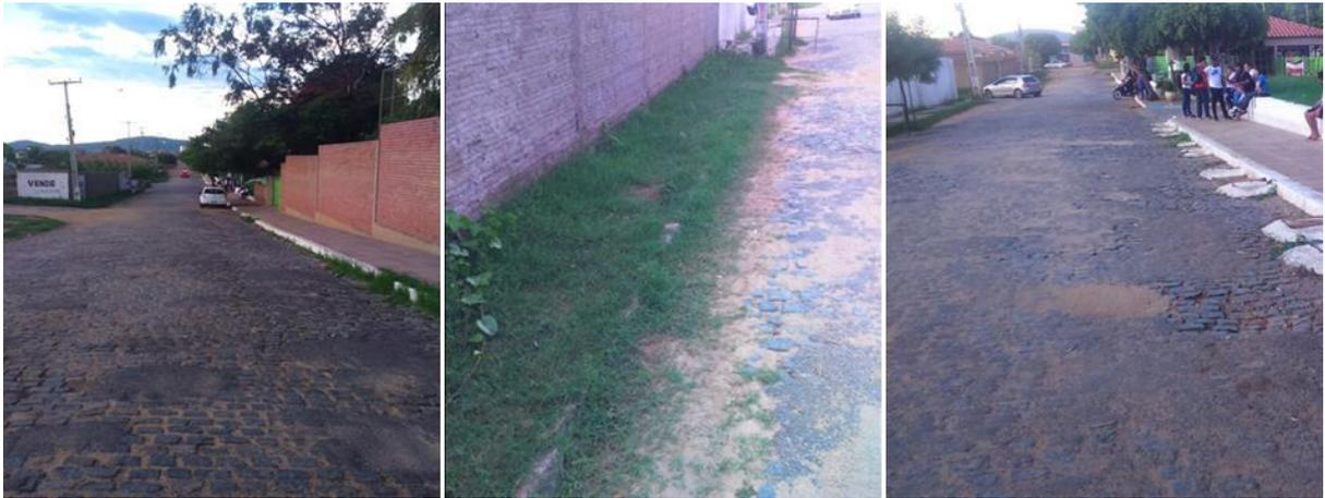
**Figura 5:** a); e b) Calçamento com ondulações e desgaste; c) ausência de faixa de pedestre frete ao Instituto.
