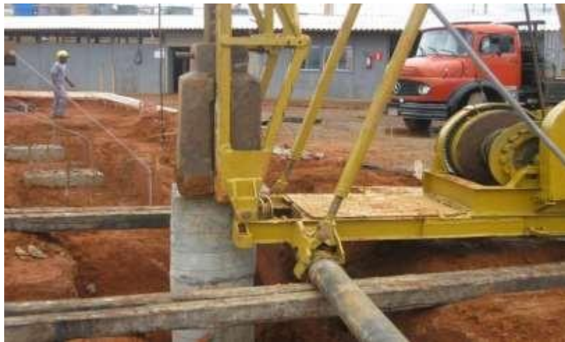
Figura 4: Ensaio de Carregamento dinâmico em Estaca Hélice Contínua. Fonte: FUNDATEST, 2015.
