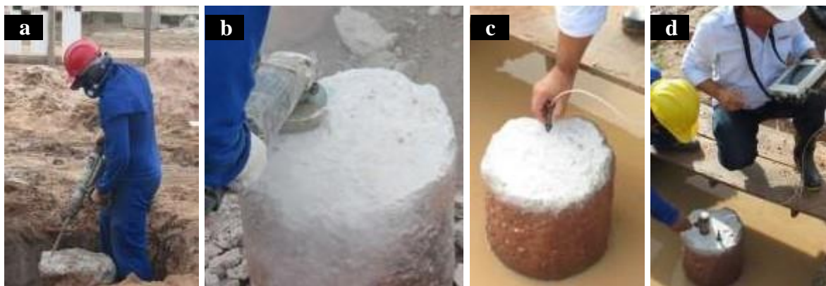
Figura 5: Execução do ensaio de integridade de estaca – PIT.
