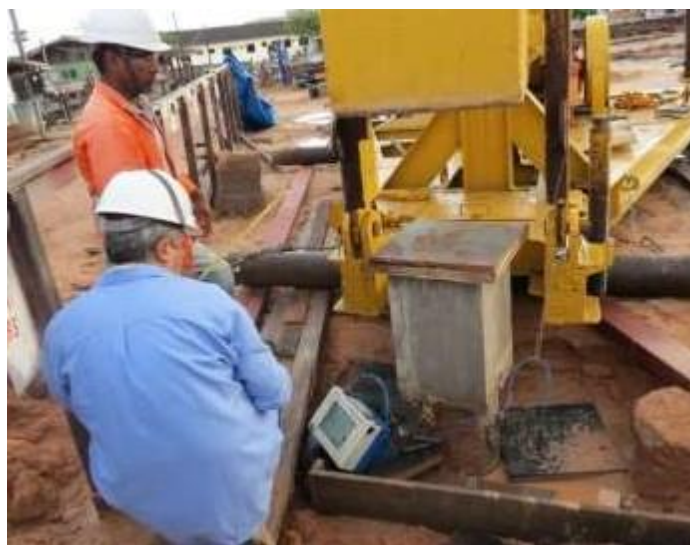
Figura 6: Execução do Ensaio PDA na estaca.
