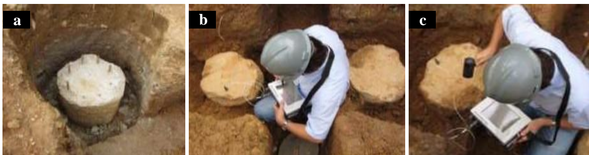
Figura 3: Execução do ensaio de integridade de estaca – PIT.
