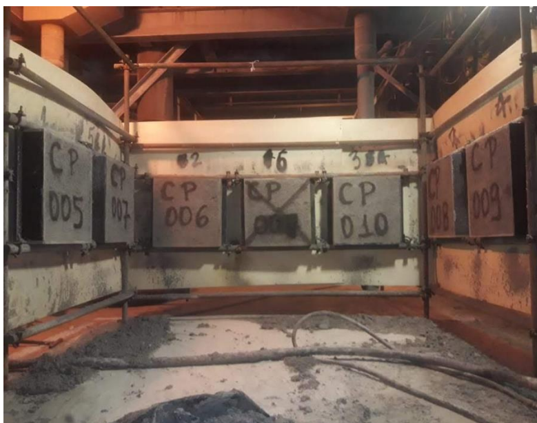
Figura 11 – Painéis com o material RD (B) aplicado por shotcrete
