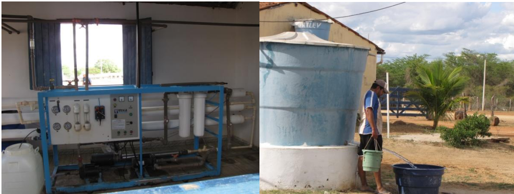
Figura 9: Dessalinizador de água e morador retirando água dessalinizada
