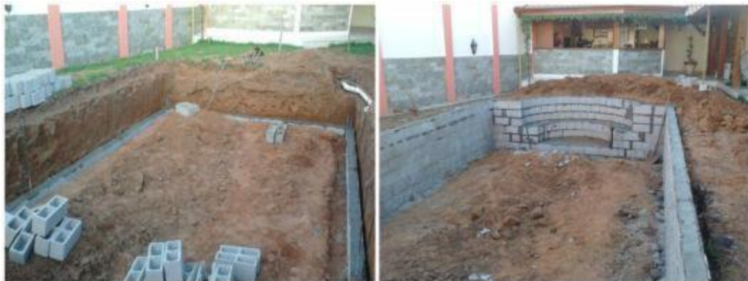
Figura 6 – Método de Construção Piscina de Alvenaria Fonte: DOCE OBRA (2018)
