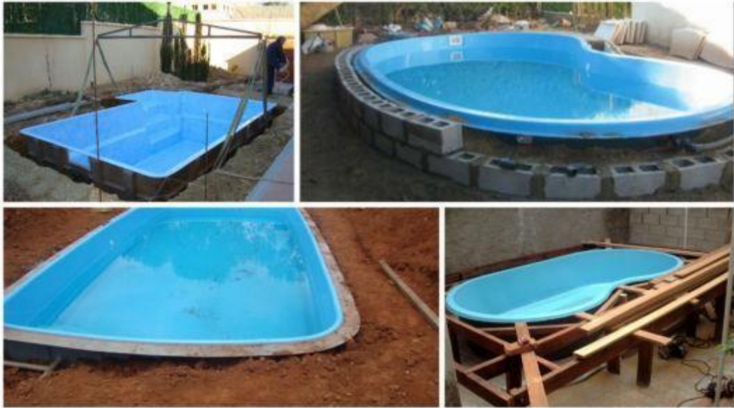
Figura 8 – Método de Instalação Piscina de Fibra Fonte: DOCE OBRA (2018)
