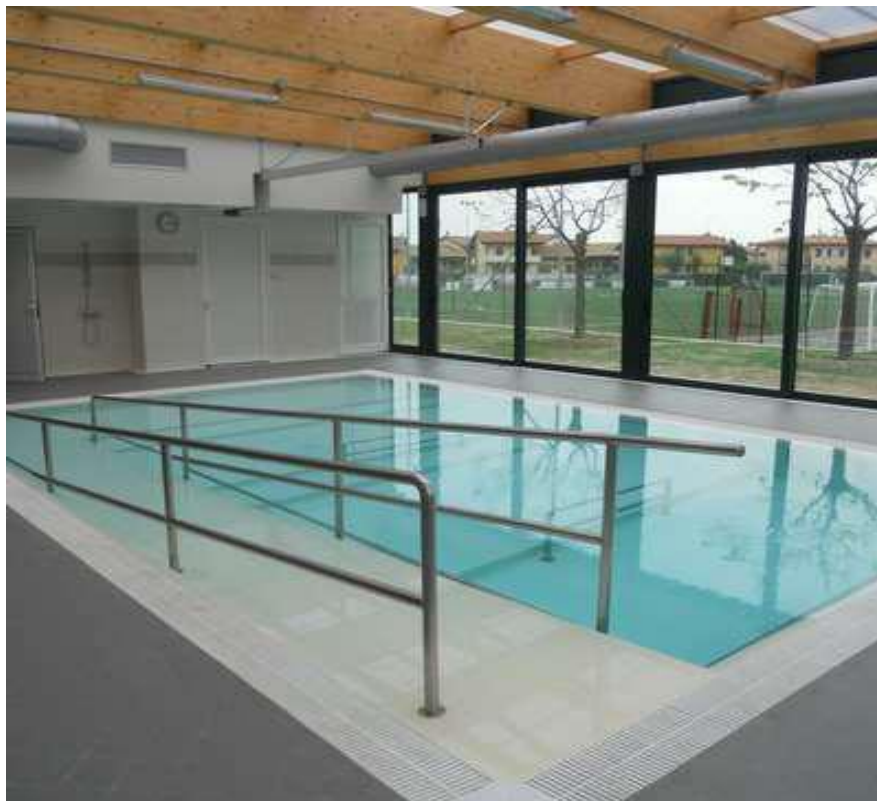
Figura 5 – Rampas, corrimãos e escadas
