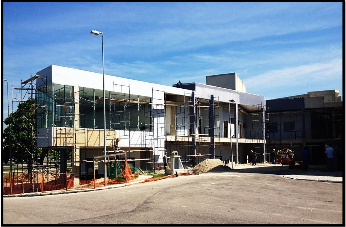
Figura 1. Obra do Prédio em construção.
