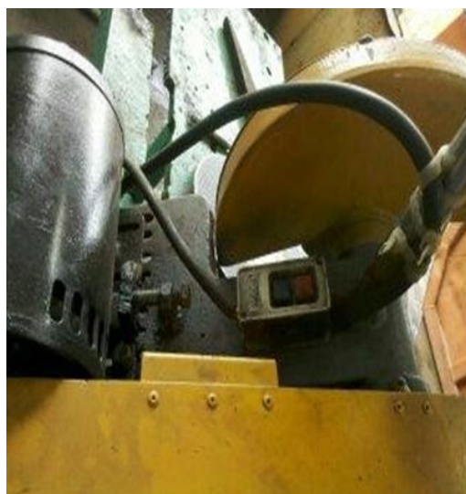
Figura 2. Sistema de acionamento
