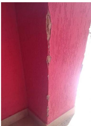
Fig. 3 – Desplacamento no pilar 2
