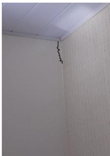
A correção das trincas e fissuras é um processo mais simples do que o anterior e pode-se aplicar uma massa de cimento e areia ou um material conhecido como veda trinca, sela trinca ou fecha trinca, dependendo da marca do fabricante. Para tanto, é necessário abrir a trinca em V, limpar o canal com uma escova para retirar pó e grãos de areia para depois aplicar a massa ou o veda trinca e finalmente pode-se realizar o acabamento necessário (normalmente massa corrida e pintura).
