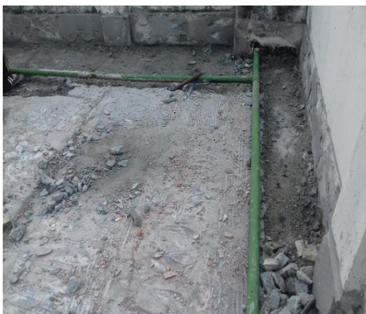
Figura 7 – Retirada das cerâmicas e do piso. Fonte Autor, 2018.
