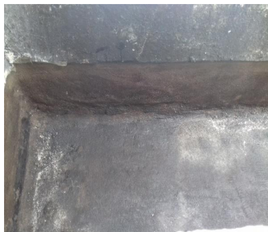
Figura 12 – Local seco pronto para receber a manta asfáltica. Fonte. Autor, 2018.
