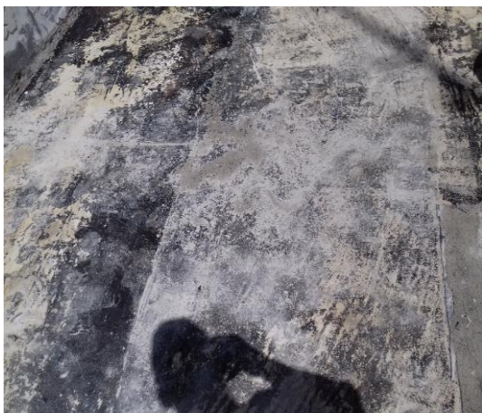
Figura 9 – Regularização da superfície para escoamento de água. Fonte. Autor, 2018.
