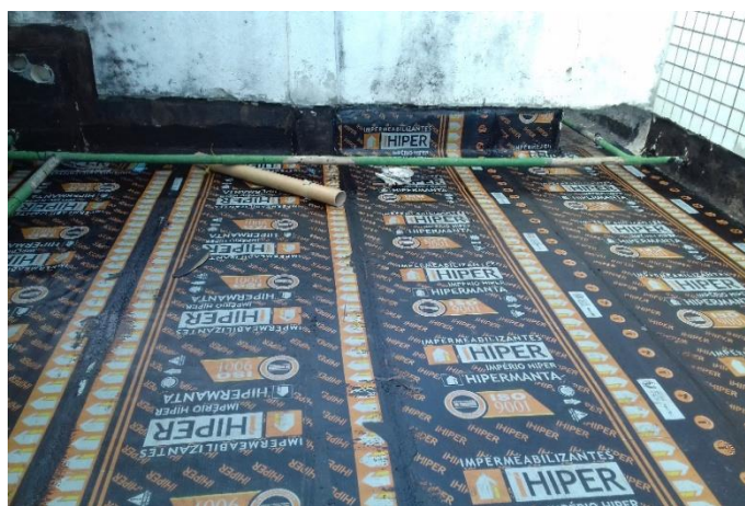
Figura 15. Laje impermeabilizada.Fonte. Autor, 2018.
