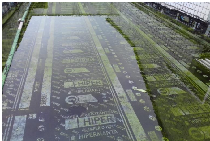
Figura 16 . Teste de estanqueidade por 72h. Fonte Autor, 2018
