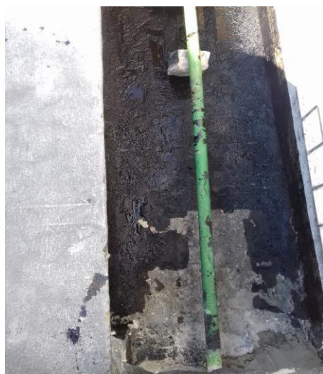
Figura 11 – Aplicação da emulsão asfáltica (PRIME). Fonte. Autor, 2018.
