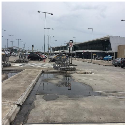
Figura 8: Acúmulo de águas pluviais Fonte: Próprio Autor
