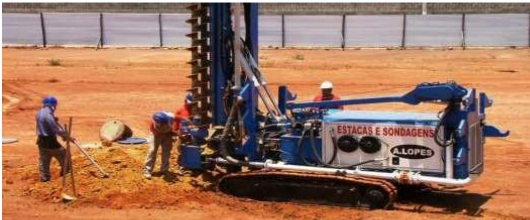
Figura 3 - Execução da estaca de concreto in loco.
