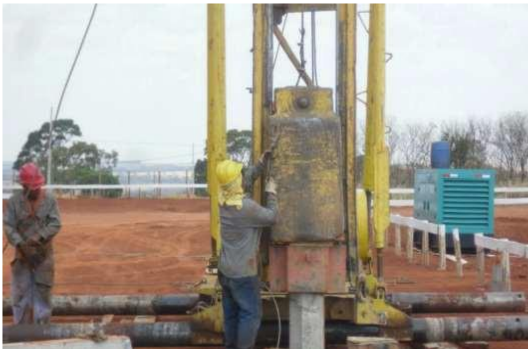
Figura 5 - Execução da estaca de concreto pré-moldada por cravação.
