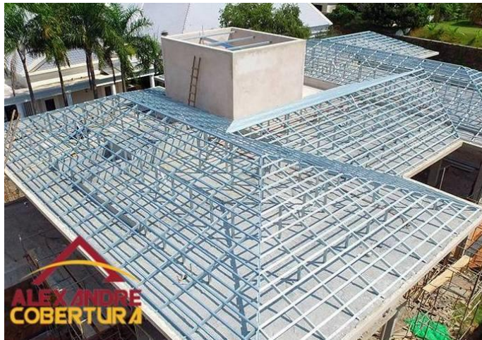
Figura 4: Elementos estruturais metálicos de cobertura Fonte: Página Alexandre cobertura 3 .
