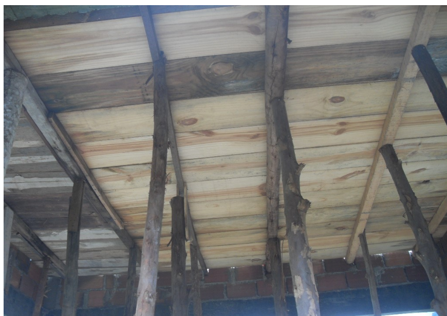
Figura 9: Laje maciça com escoramento. Fonte: Bombeamento de Concreto, 2013.
