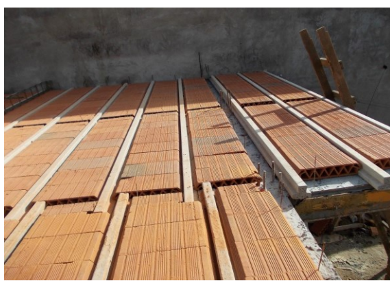
Figura 12: Laje Pre-moldada com lajota cerâmica. Fonte: Construdeia, 2017.
