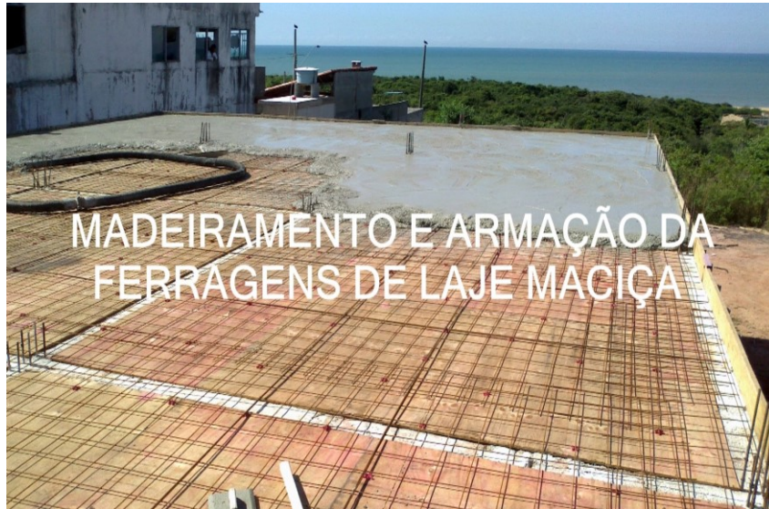
Figura 8: Laje de concreto maciça, armadura e concretagem. Fonte: FirePont, 2018.
