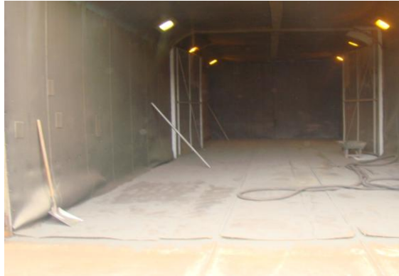
Figura 1: Cabine de jateamento de granalha de aço
