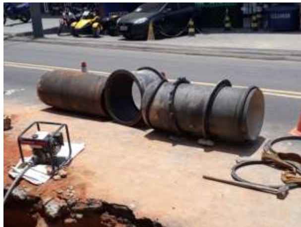
Figura 17 - Tubulações que foram trocadas. Foto: Acervo próprio
