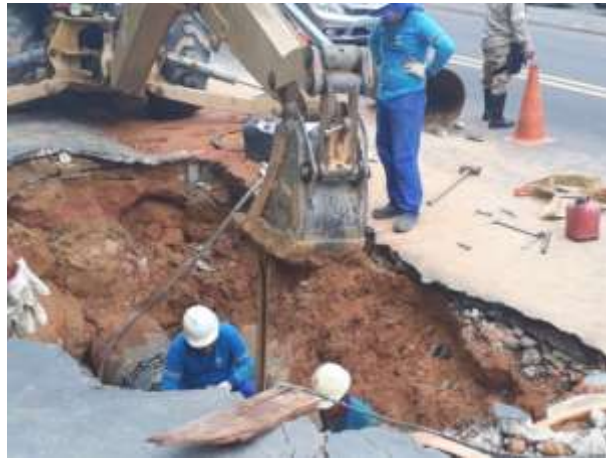
Figura 19 - Equipe da Manaus Ambiental, trabalhando na recuperação da tubulação. Foto: Acervo próprio
