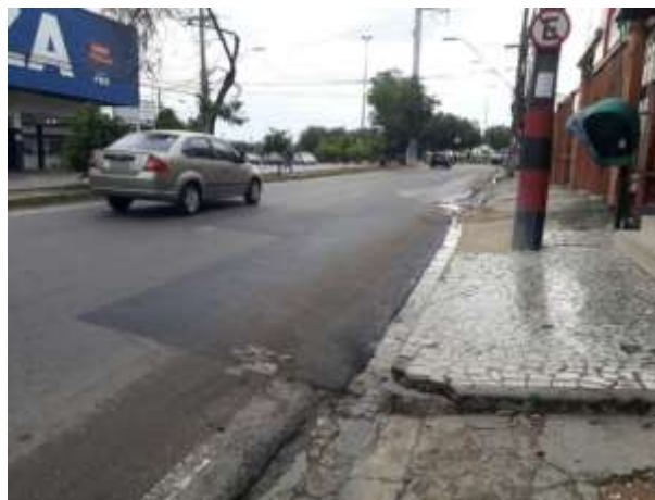
Figura 9 - Avenida Costa e Silva com o pavimento restaurado. Fonte: Acervo pessoal
