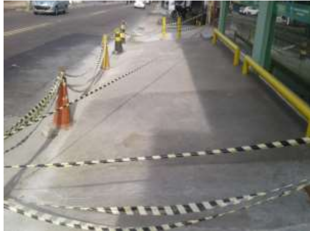
Figura 23 - Calçada e via recuperados, dezesseis dias após o rompimento. Foto: Acervo próprio
