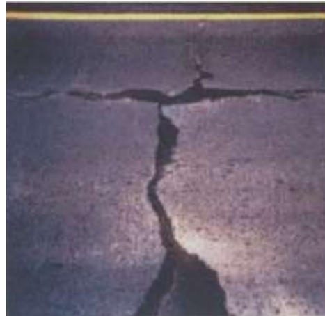
Figura 3 - Fotografia de fendas de onde ocorre a subida de finos. Fonte: Pinto, 2003, p. 51
