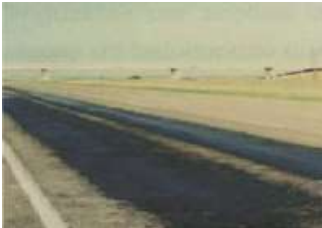
Figura 2 - Ilustração da exsudação na parte. Fontes: Bernucci, 2006, p. 420; Pinto, 2003, p. 52; Silva, 2008, p. 33
