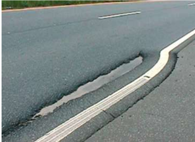
Figura 5 - Fotografias do escorregamento de revestimento. Fontes: Bernucci, 2006, p. 420; Brasil, 2003, p. 9; Silva, 2008, p. 35.
