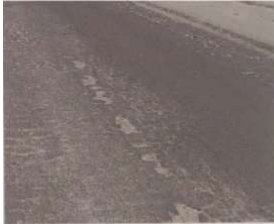
Figura 7 – Exemplo de Pelada. Fonte: Pinto, 2003, p. 53.
