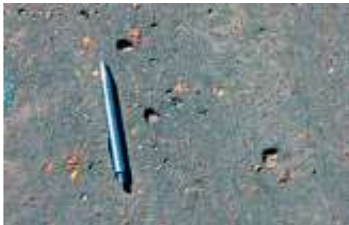
Figura 4 - Deslocamento e perda de agregado. Fonte: Bernucci, 2006, p. 11; Bernucci, 2006, p. 421; Bernucci, 2006, p. 421, Brasil, 2003, p. 421
