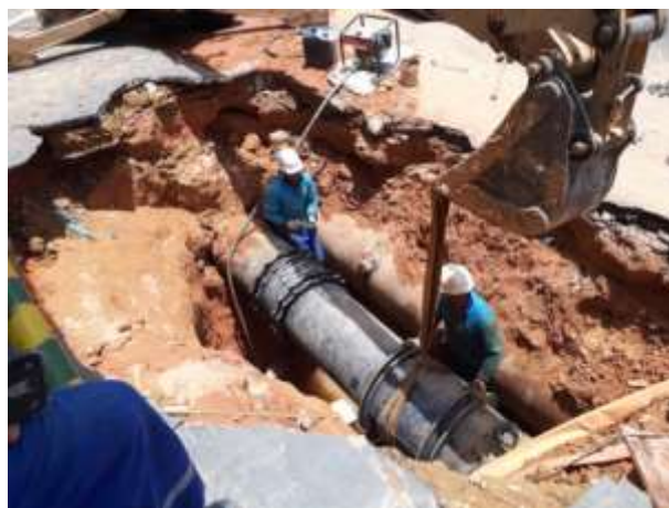
Figura 20 - Equipe da Manaus Ambiental retirando a tubulação danificada. Foto: Acervo próprio
