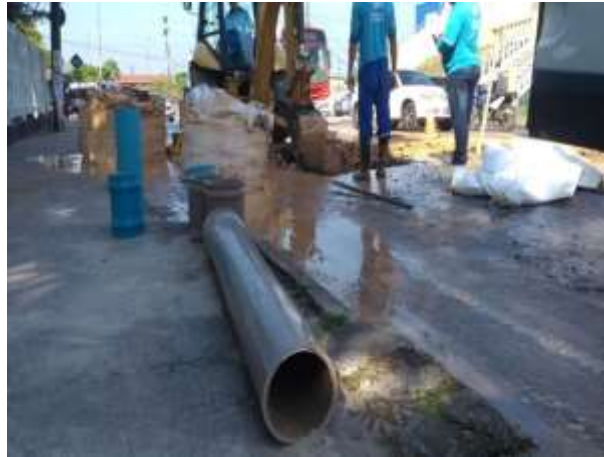
Figura 14 - Tubulação que foi usada para substituir a danificada. Foto: Paulo Paixão/Rede Amazônica
