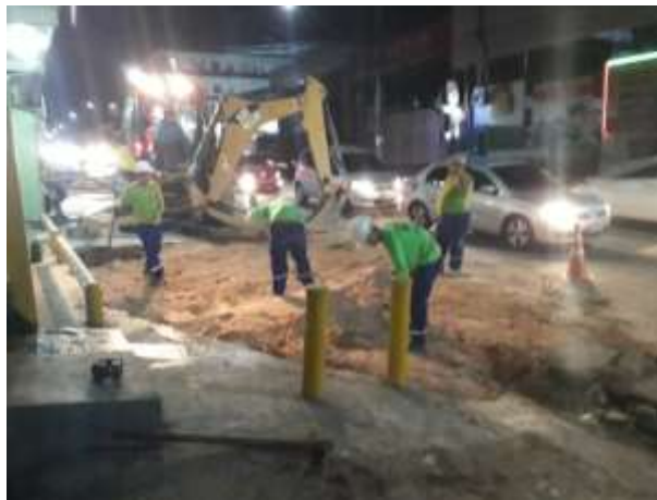
Figura 21 - Equipe da Seminf realizando o processo de aterro. Foto: Acervo próprio
