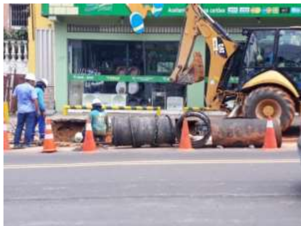
Figura 18 - Local interditado, durante as obras de reparo. Foto: Acervo próprio
