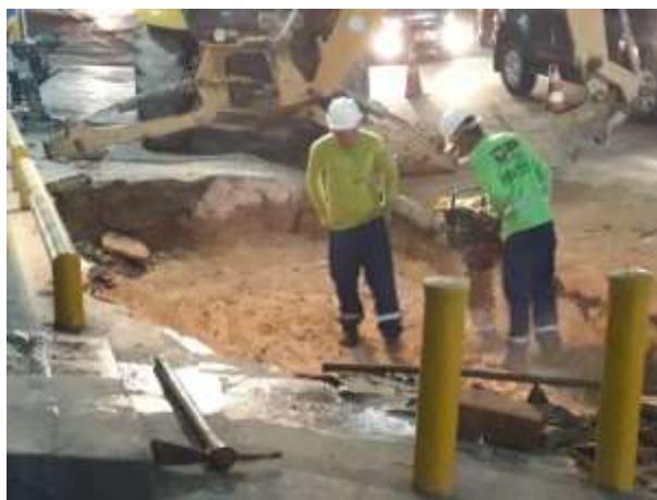
Figura 22 - Equipe da Seminf realizando o serviço de compactação no local. Foto: Acervo próprio
