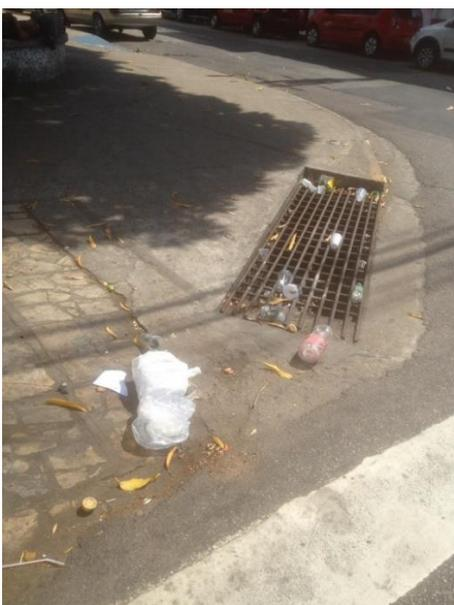
Figura 67: Grelha que impede circulação. Fonte: Autor (2018).
