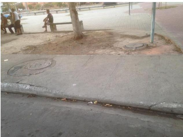
Figura 91: Calçada sem rebaixamento.
