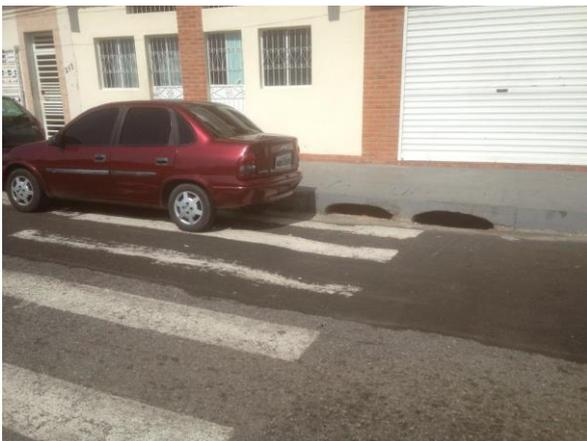
Figura 46: Guia sem rebaixamento.
