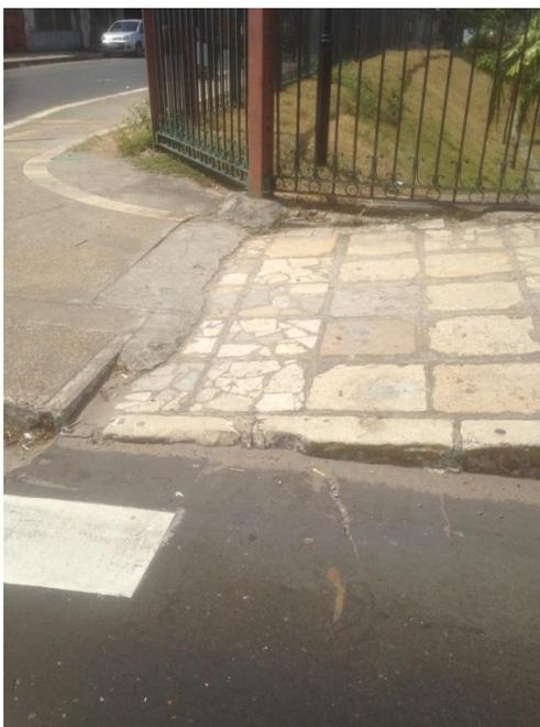
Figura 58: Rebaixamento inadequado da guia. Fonte: Autor (2018).
