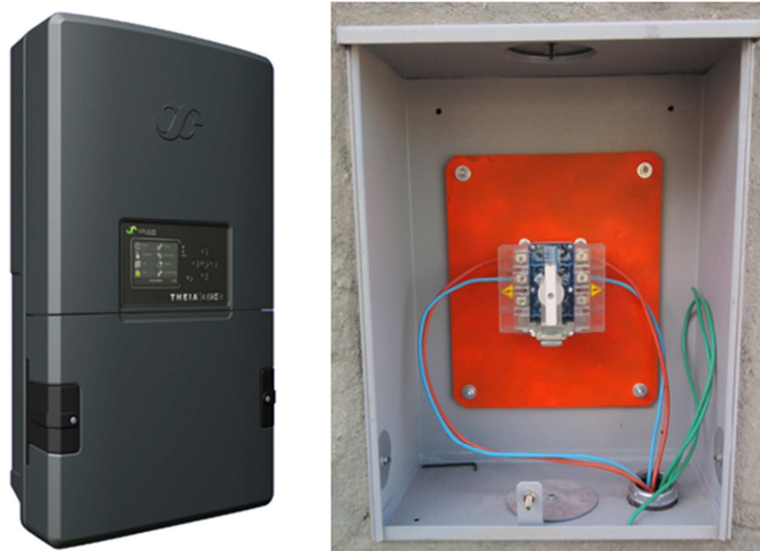
Figura 18 – Inversor, DSV e caixa CM-DSV.
