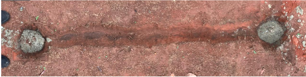
Figura 8: Hastes linear preenchidas com concreto fabricado.
