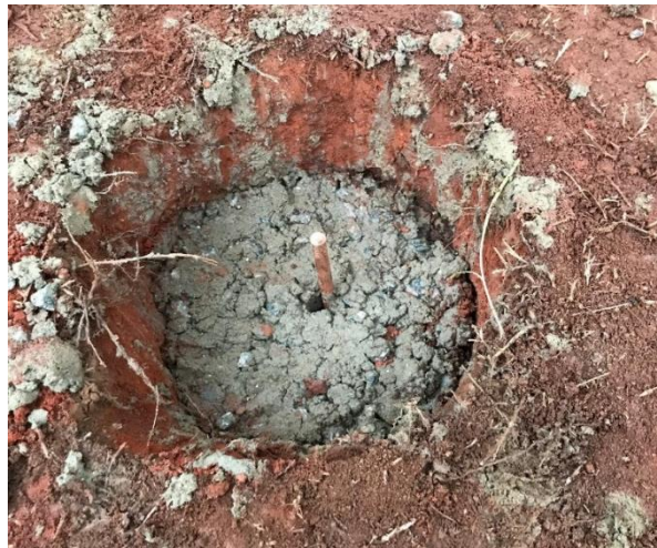
Figura 7: Buraco preenchido com concreto fabricado e haste no centro.
