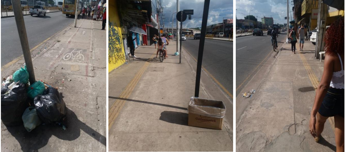
Figuras 11, 12 e 13: Condições das calçadas e ciclovias no trecho 2.
