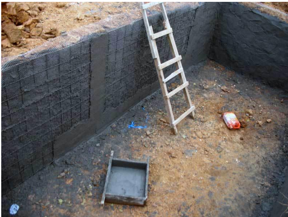
Figura 9: Revestimento e impermeabilização. Imagem de internet.
