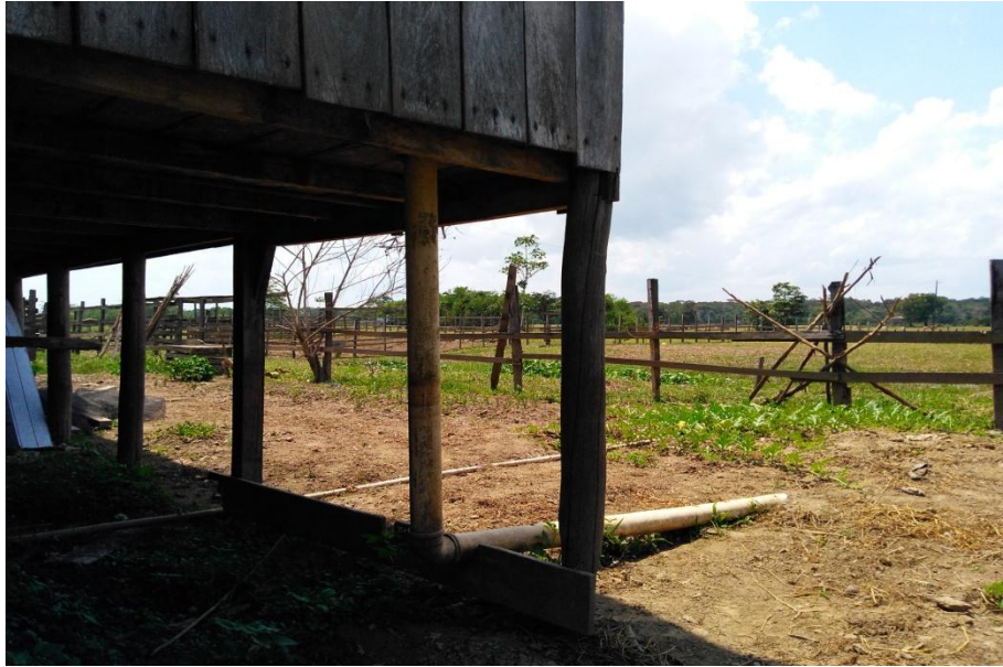
Figura 7: Tubulação de esgoto sanitário diretamente na fossa rudimentar. Fonte: Autor, 09/2018.
