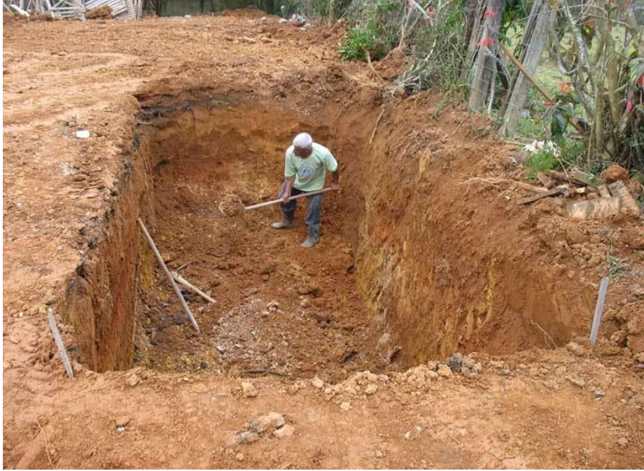
Figura 8: Escavação de uma BET. Imagem de Internet.
