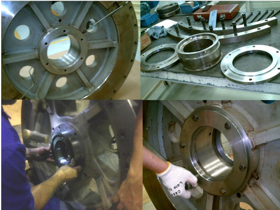
Figura 5 – Desmontagem do volante da prensa.
