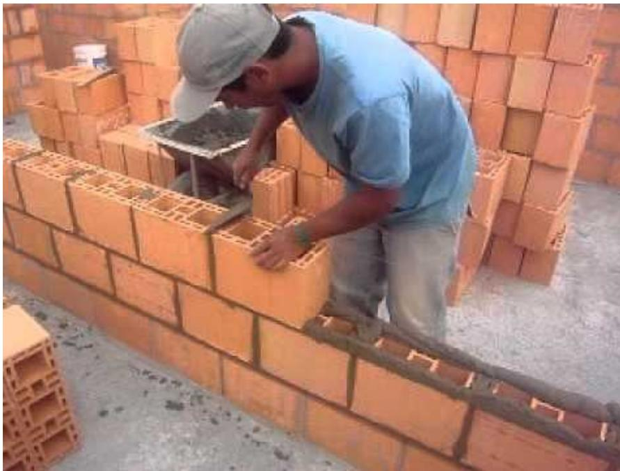
Figura 3: Colaborador assentando blocos cerâmicos na construção. [19]
