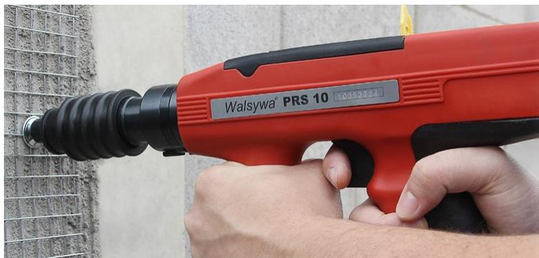
Figura 6: Pistola Finca-Pinos fixando tela de armação na alvenaria estrutural. [18]
