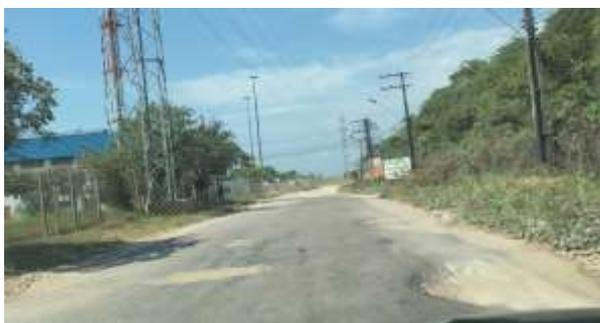
Figura 2 – Segmento em estado Falimentar, apresentando Panelas e Afundamentos Severos
