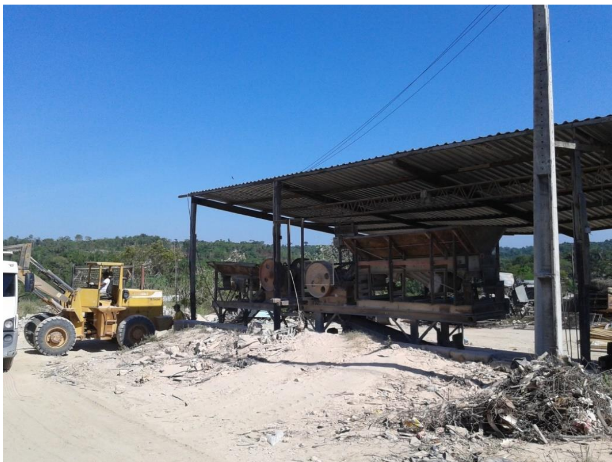
Fig.3- britador em operação Fonte: Autor (2018)
