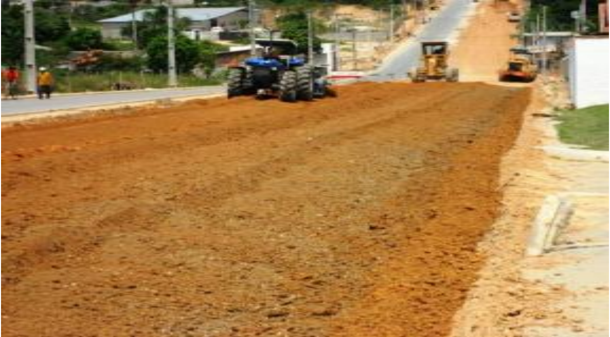
Figura 8: Incorporação do cimento Portland ao solo. Fonte: Próprio autor, 2018.
