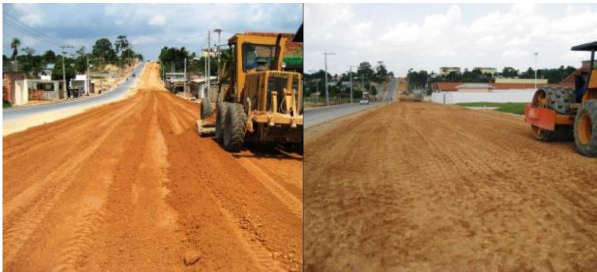
Figura 10: Procedimento de compactação. Fonte: Próprio autor, 2018.
