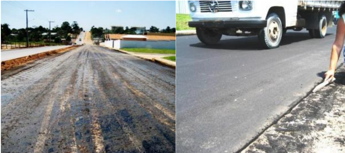
Figura 11: Imprimação a cura e camada asfáltica. Fonte: Próprio autor, 2018.
