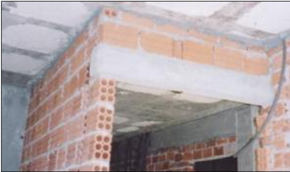
Figura – 10 – Vigas pré-moldadas.
