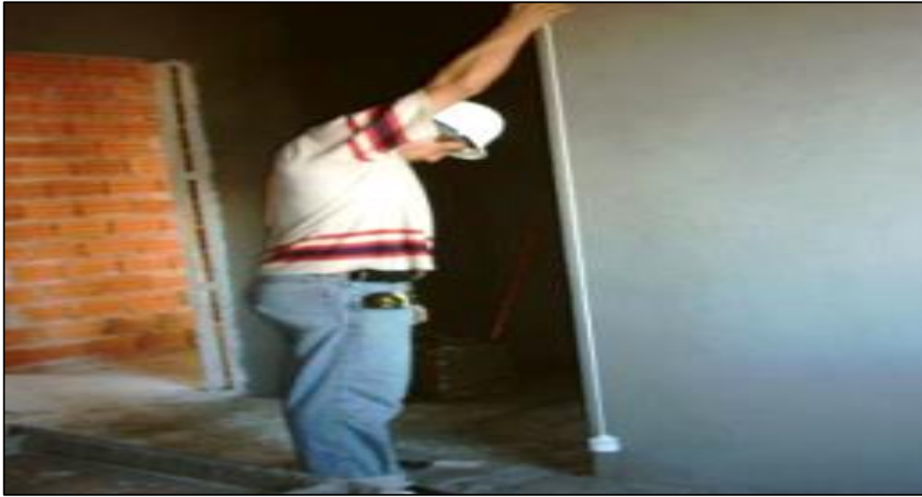
Figura – 06 – Inspeção periódica dos serviços.
