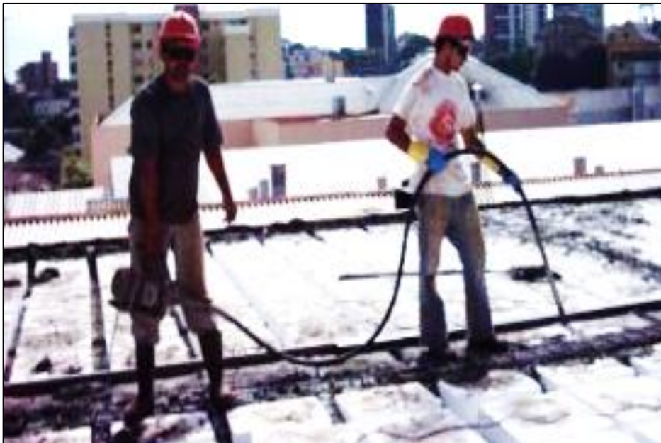
Figura – 04 – Utilização de um Vibrador convencional.
