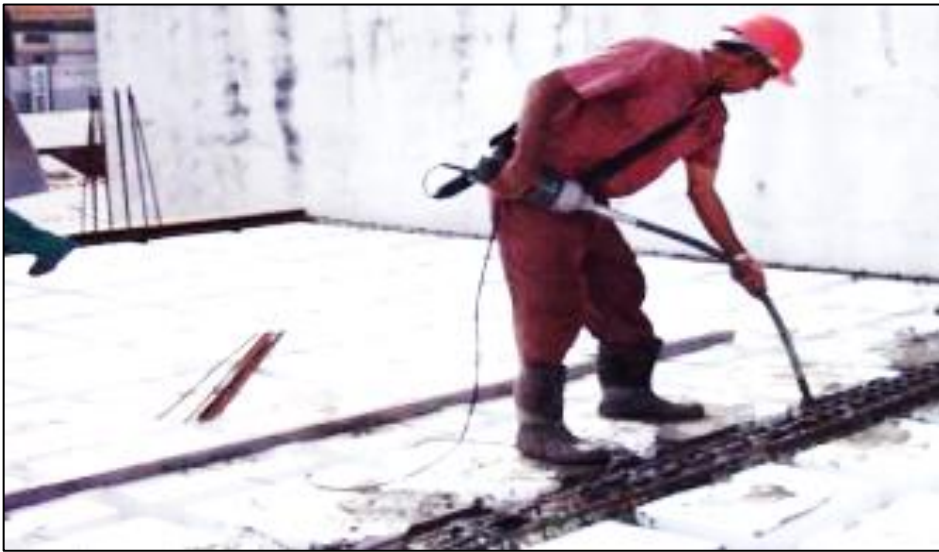
Figura – 05 – Utilização de um Vibrador Portátil.
