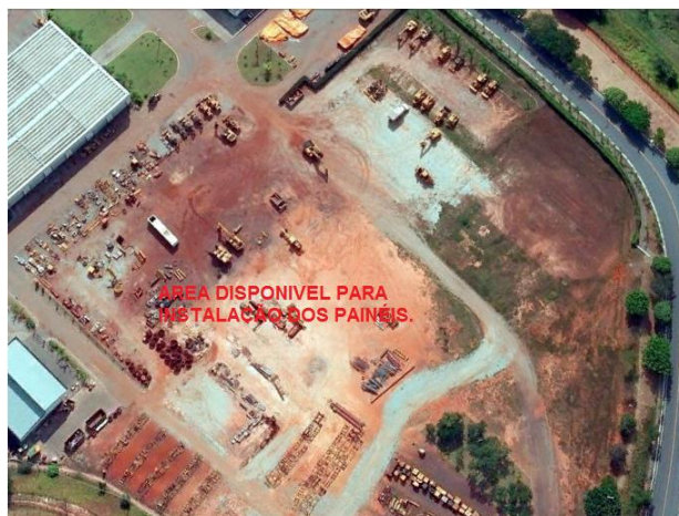
Figura 6 - Vista aérea da área disponível para instalação do sistema fotovoltaico.
