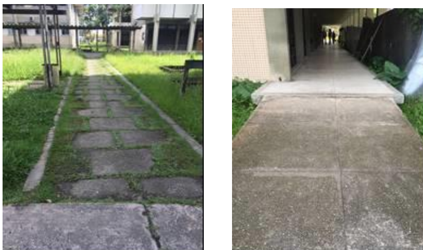
Figura 20 e 21 – Calçada de acesso ao banheiro
