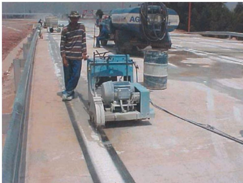
Figura 7: Figura meramente ilustrativa do corte e selagem das juntas. Fonte: PR-4, ABCP, 2003.
