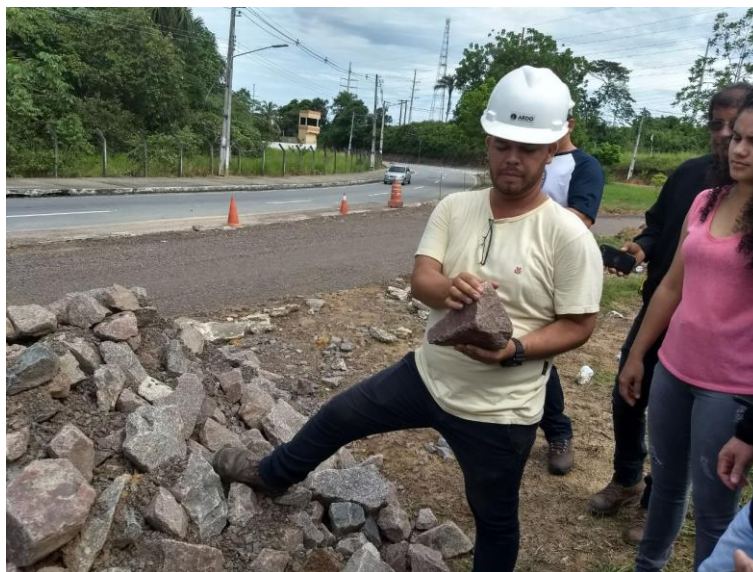
Figura 5: Material para utilização na sub-base. Fonte: Autor próprio, 2018.
