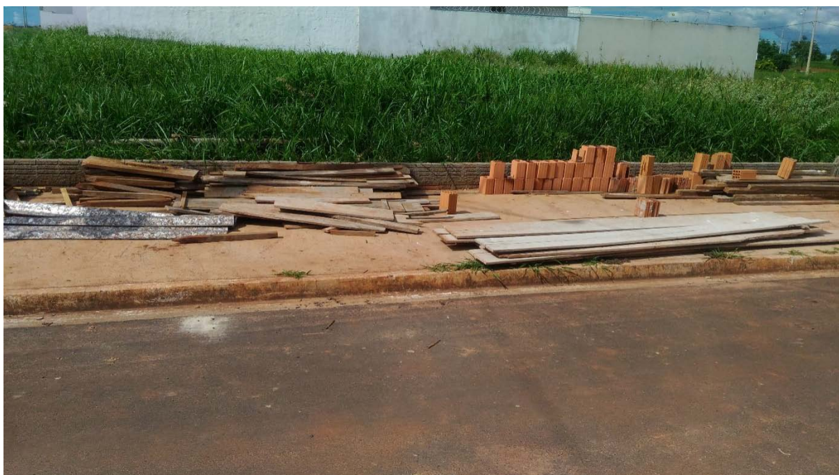
Figura 2 – Entulho de construção encontrado em passeio público.
