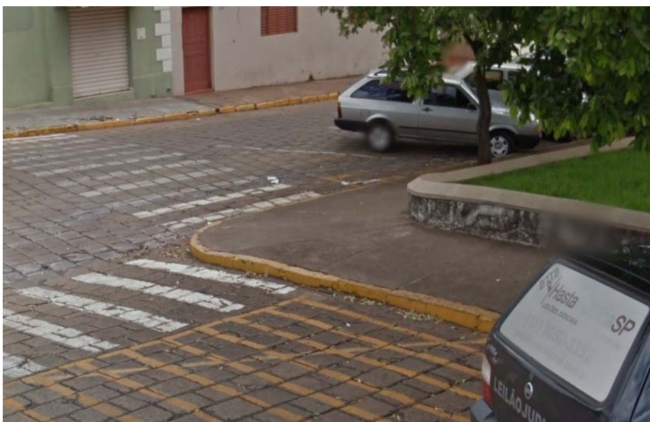
Figura 4– Passeio ao lado do Fórum Municipal antes de ser reformado
