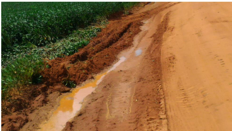
Figura 10 – Formação de Atoleiros ao longo da borda da pista. Fonte: O autor.
