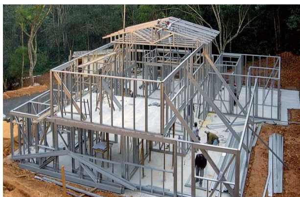
Figura 01: Construção feita em Light Steel Frame
