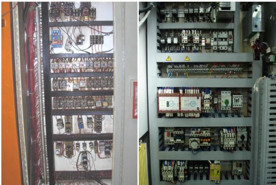
Figura 1: Painel elétrico antes e depois do Retrofit.
