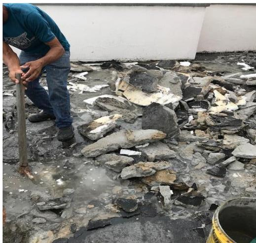
Figura 6 – Retirada piso existente. Fonte: Próprio autor
