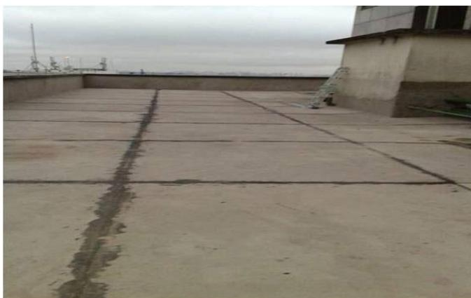
Figura 13 – Proteção mecânica já com juntas de dilatação. Fonte: Glengenharia
