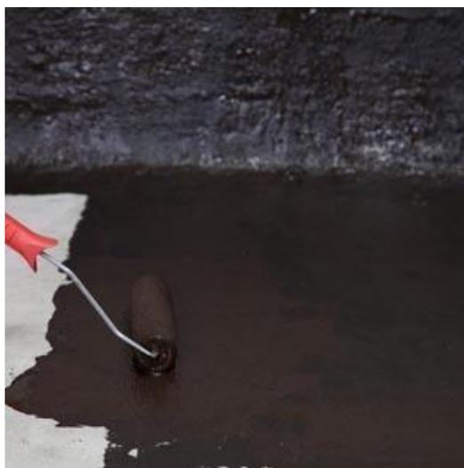
Figura 9 – Processo de imprimação do piso. Fonte: Próprio autor
