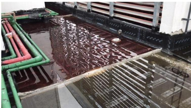
Figura 12 – Teste de Estanqueidade de 72 horas. Fonte: Próprio autor
