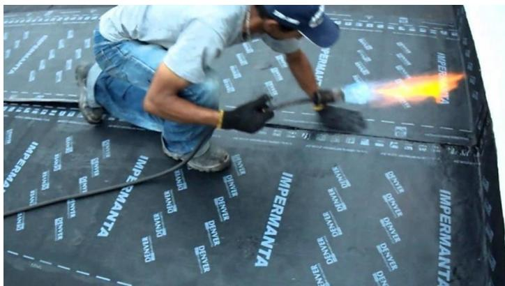
Figura 10 – Aplicação da manta com maçarico. Fonte: Próprio autor
