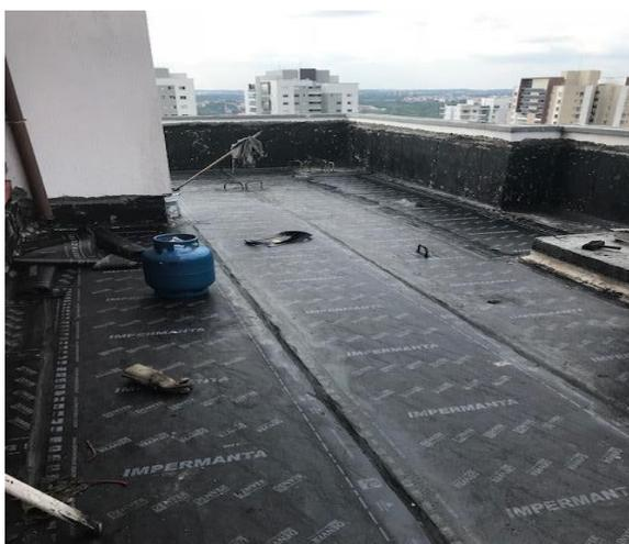
Figura 11 – Manta já aplicada uniformemente. Fonte: Próprio autor
