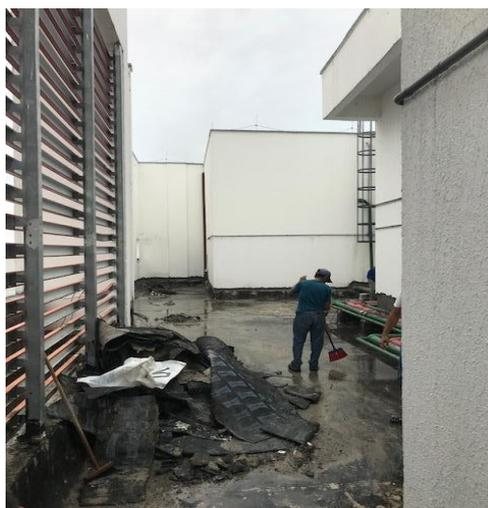
Figura 7 – Retirada da manta asfáltica existente. Fonte: Próprio autor
