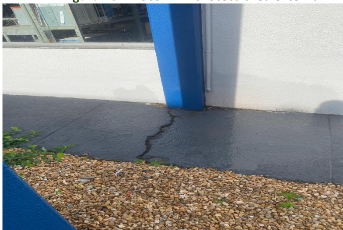
Figura 10. Bloco F - Biblioteca área externa
