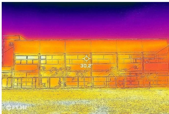
Figura 6. Lado esquerdo - bloco administrativo
