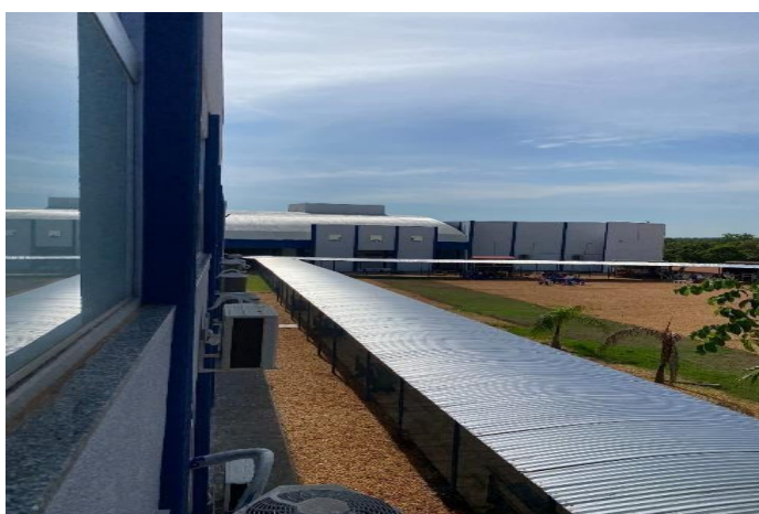
Figura 5. telhado de zinco - bloco administrativo
