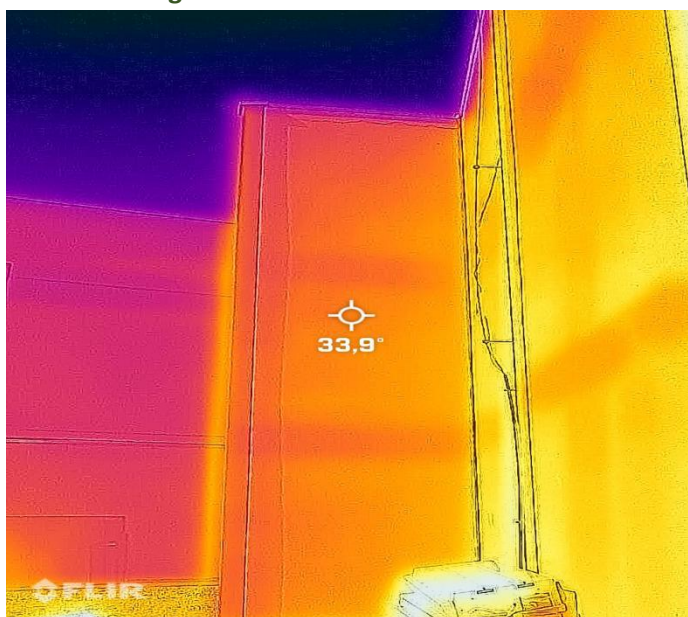
Figura 8. Bloco F - Parede externa
