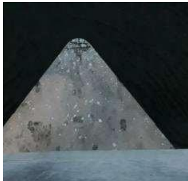
Figura 38a: Bloco de coroamento Pilar da Ponte Dep. Wilson Mendes (2019)
