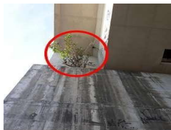
Figura 22a: Vista lateral esquerda km 14,1 – Pilar da ponte (2019)
