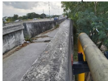
Figura 29b: Abatimento no passeio (2021)
