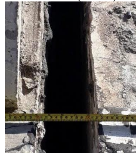
Figura 26b: Junta de dilatação - km 14,15 Pista Sentido Cabo Frio – São Pedro da Aldeia (2021)
