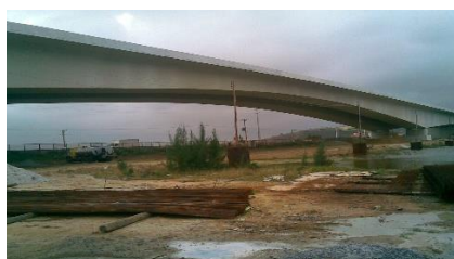
Figura 20: obras da Ponte Dep. Wilson Mendes
