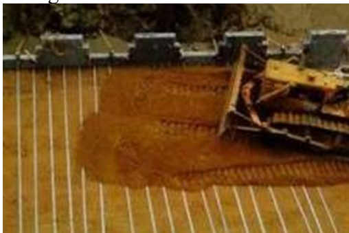
Figura 12: Terra Armada – Aterro
