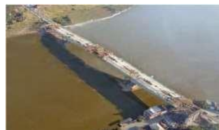
Figura 19: Vão central da Ponte Dep. Wilson Mendes
