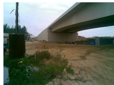
Figura 17: Construção da Ponte Dep. Wilson Mendes
