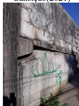
Figura 31b:Deslocamento da laje de transição(2021)
