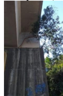
Figura 23b: Vista lateral direita km 14,1 – Pilar da ponte (2021)
