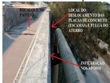
Figura 29a: Abatimento no passeio (2019)
