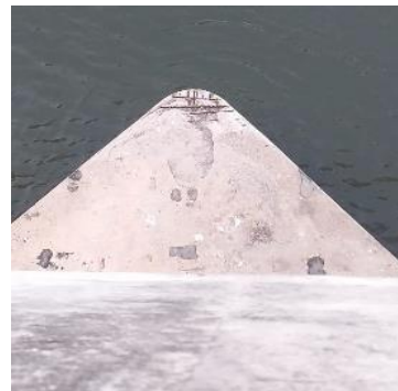
Figura 38b: Bloco de coroamento da Ponte Dep. Wilson Mendes (2021)
