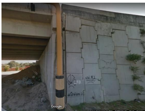
Figura 39: Margem Direita do Canal Palmer, lado direito da ponte
