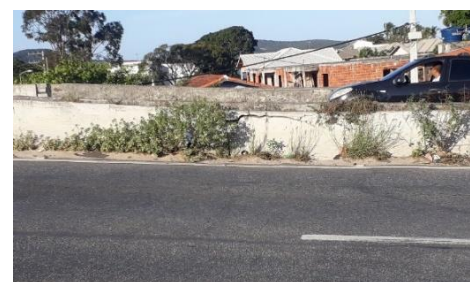
Figura 33b: Margem esquerda do canal - Lado esquerdo da Ponte sobre o canal Palmer(2021)
