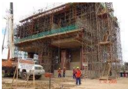
Figura 16: Construção da Ponte Wilson Mendes
