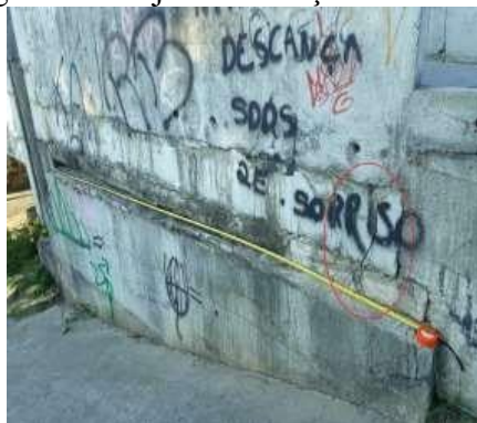
Figura 30: Laje de transição no encontro
