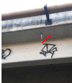
Figura 36a: Pingadeira no vão da ponte
