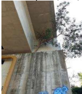
Figura 23a: Vista lateral direita km 14,1 – Pilar da ponte(2019)
