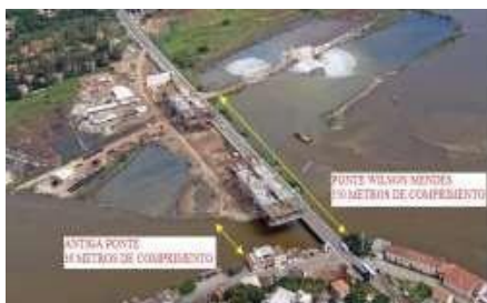
Figura 18: Construção da Ponte Dep. Wilson Mendes
