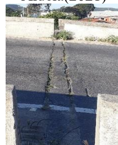
Figura 27b: Junta de dilatação - km 14,15 Pista Sentido Cabo Frio – São Pedro da Aldeia(2021)
