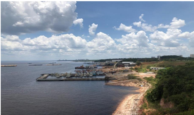
Figura 6 - Vista da Orla do bairro da Compensa onde é proposta a construção do novo Terminal Hidroviário de Cargas de Manaus. Fonte: Maria Ariely, Milena Karina (Out/2018).
