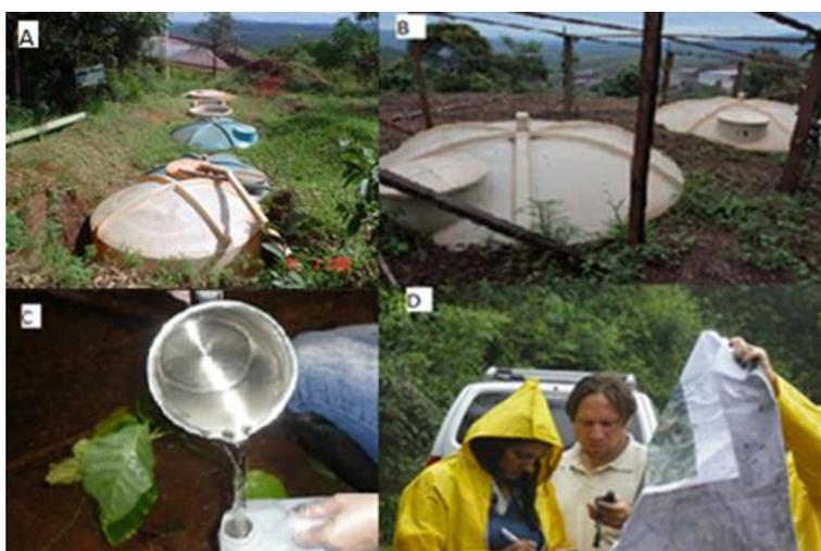
Figura 1 – A- Fossa séptica sistema antigo; B- Fossa séptica sistema novo; C- coleta de amostras sem degradação aparente; D- anotação das coordenadas do ponto visitado e tomada de nota da descrição geral do ponto.
