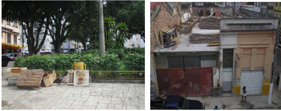
Figura 1 – Depreciação e mal uso de equipamentos urbanos da Praça dos Remédios. Ao lado, destruição e descaracterização de imóveis classificados como patrimônios de 2º grau, na Rua Loveogildo Coelho, em Manaus.
