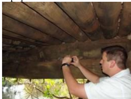
Figura 8: Inspeção Visual em uma Estrutura de Madeira
