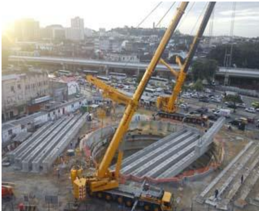
Figura 3 Vista da obra do reservatório na Praça da Bandeira Fonte: Jornal EXTRA / O Globo.
