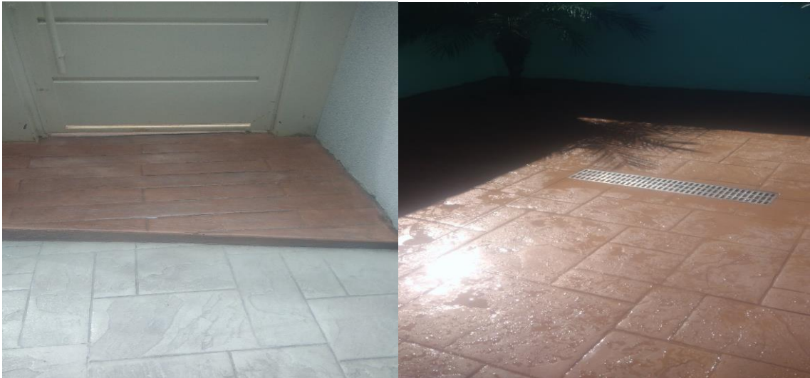
FIGURA 13-14: PISOS DE CONCRETO ESTAMPADO RESINADOS E ACABADOS
