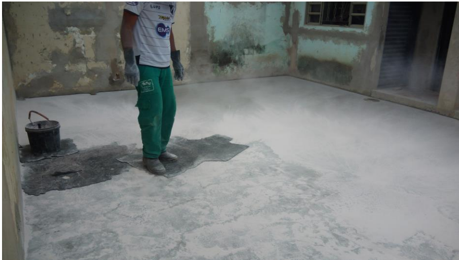
FIGURA 12 – ESTAMPAGEM PISO DE CONCRETO ESTAMPADO.
