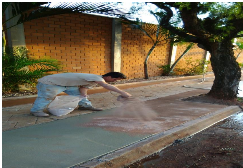
FIGURA 11 – LANÇAMENTO DO CIMENTO COLORIDO NA SUPERFÍCIE.
