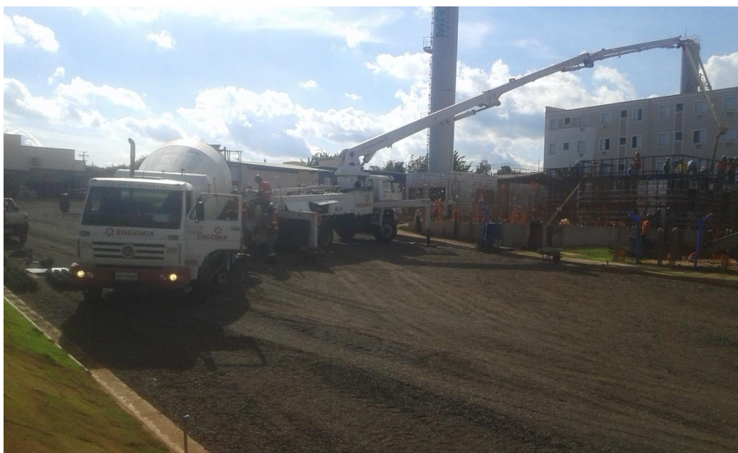
Figura 5 - Concretagem das formas, concreto auto adensável.
