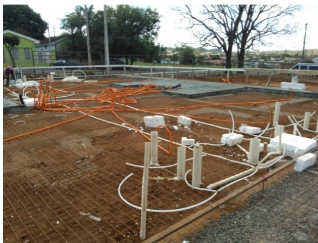
Figura 8 – Montagem da laje-radier
