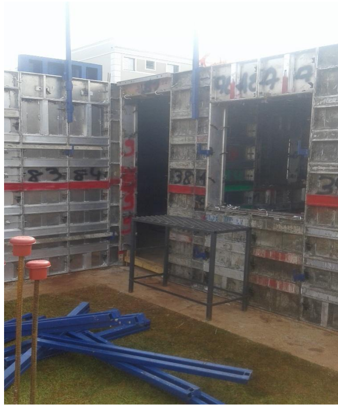
Figura 2: Formas metálicas, vista interna da edificação 2.
