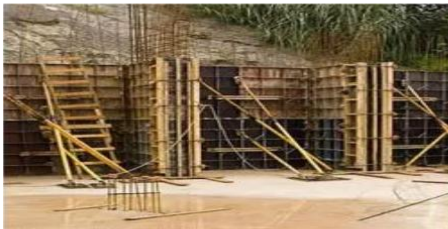
Figura 3 – Fôrma de madeira.
