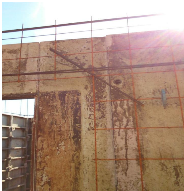
Figura 9 - Vergalhões a 45 graus para reforços de cantos de esquadrias
