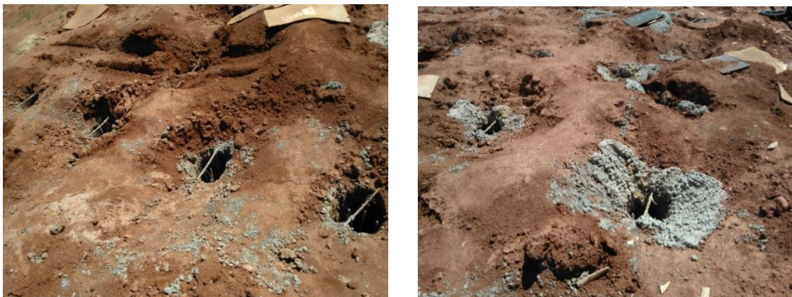
Figura 6 - Estaca escavada.
