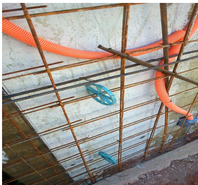
Figura 10 - Espaçadores e conduítes arranjados nas telas
