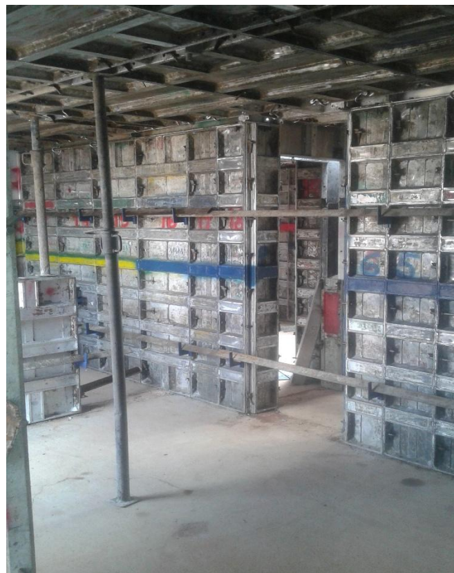
Figura 2: Formas metálicas, vista interna da edificação 2.
