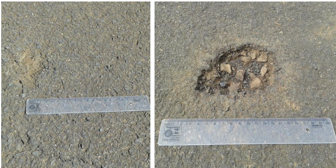
Figura 7. Defeito ASTM nº12 M e ASTM nº12 A respectivamente.
