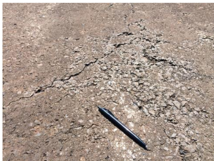
Figura 9. Defeito ASTM nº8 e ASTM nº1
