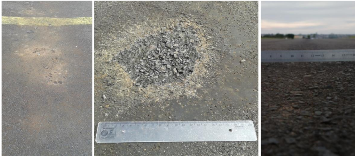
Figura 8. Defeito ASTM nº5 A, ASTM nº9 e ASTM nº13 B respectivamente.
