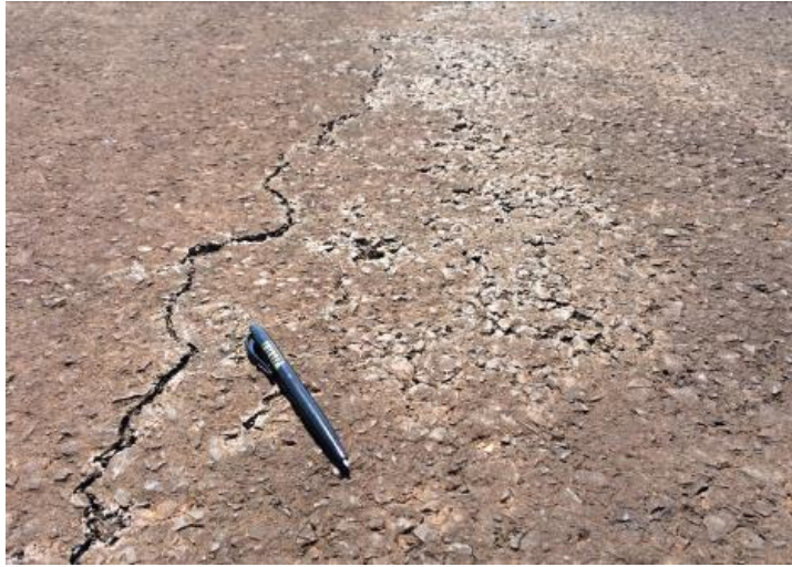
Figura 10. Defeito ASTM nº8 M e ASTM nº12
