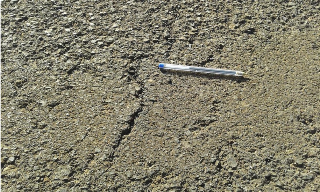
Figura 2. Defeito ASTM nº8, severidade baixa
