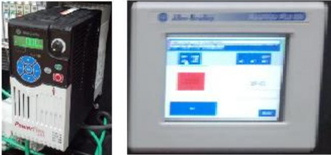
Figura 11: Inversor de Frequência e Interface Homem-Máquina
