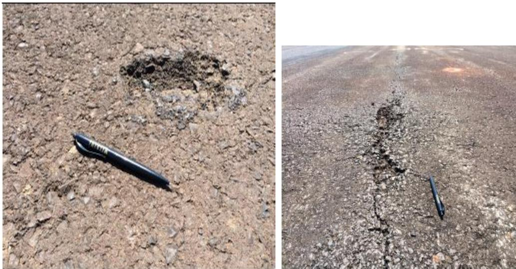
Figura 4. Buracos na camada superficial do pavimento
