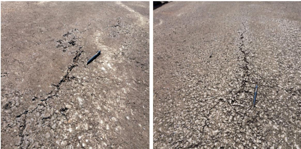
Figura 3. Desgaste do pavimento betuminoso e desagregação do revestimento
