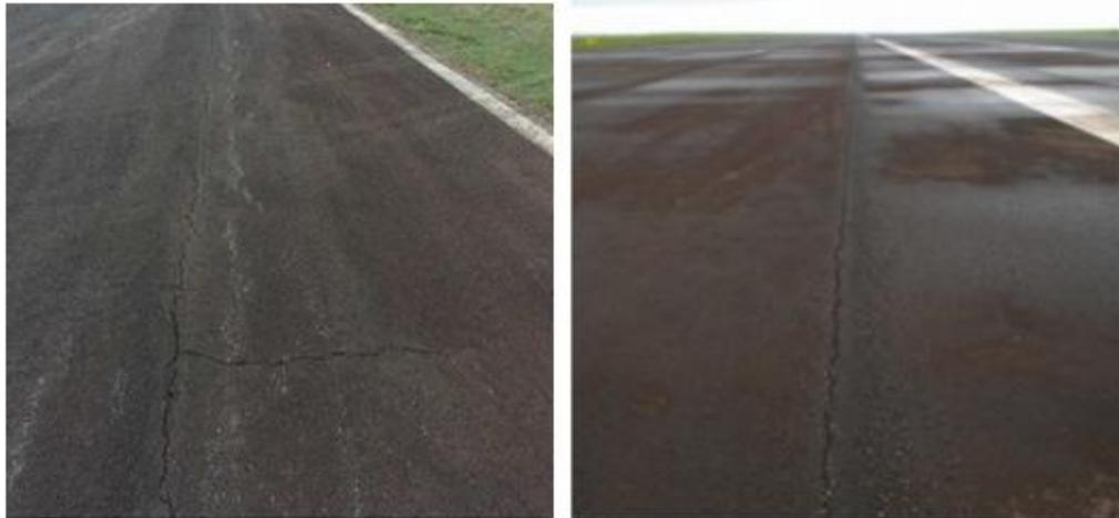
Figura 1. Fenda longitudinal e transversal
