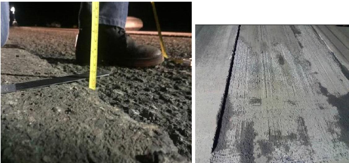
Figura 5. Corte e fresagem a frio do pavimento
