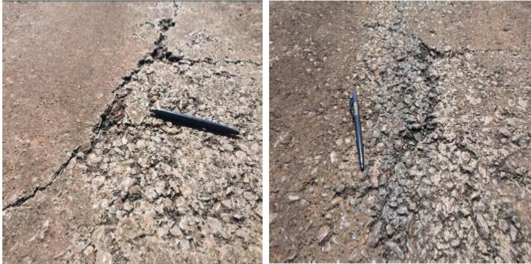
Figura 2. Fendilhamento por fadiga ou Pele de Crocodilo
