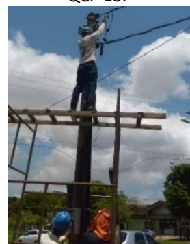
(h) Conexão dos cabos de alimentação do QCF-17 na MR.
