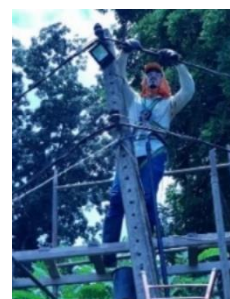
(d) Preparação os cabos da rede para conexão com o QCF-13.
