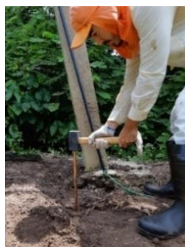
(g) Fixação da haste de aterramento no Poste 13.
