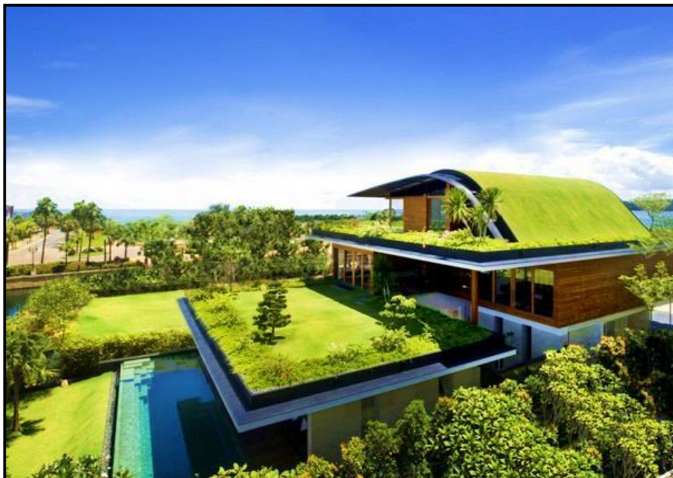
Figura 1: Telhado Verde em Singapura.
