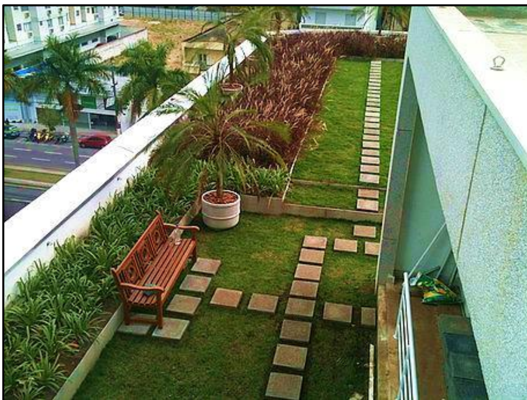
Figura 11: Telhado Verde do tipo Intensivo-Elementar.
