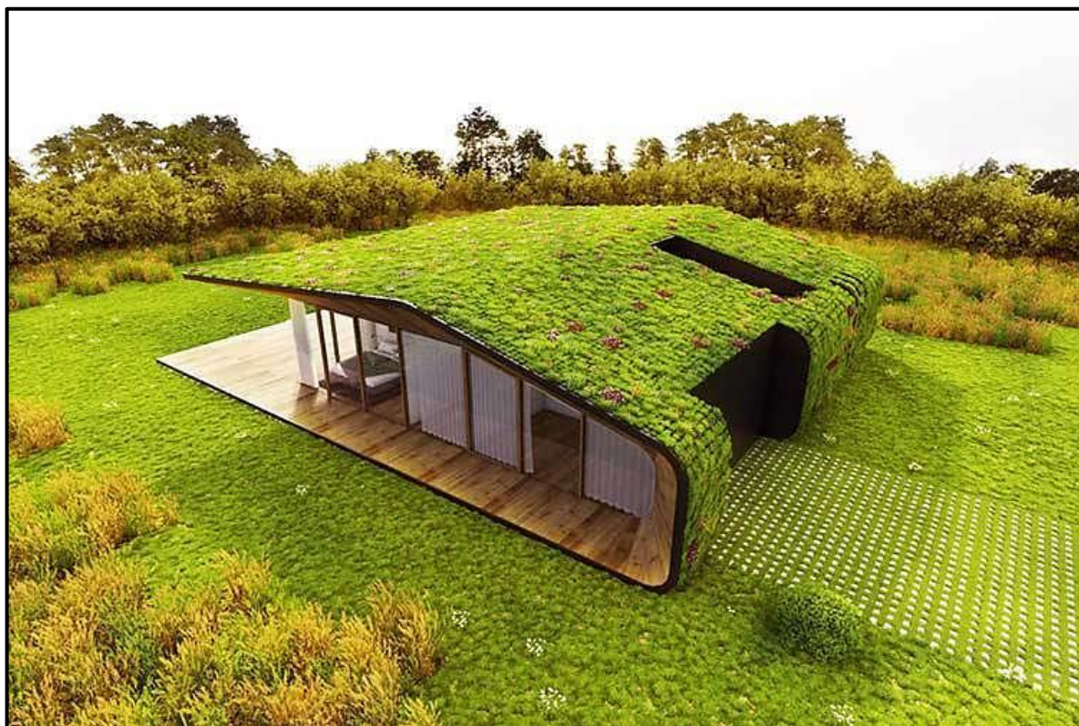
Figura 9: Telhado Verde do tipo Extensivo.
