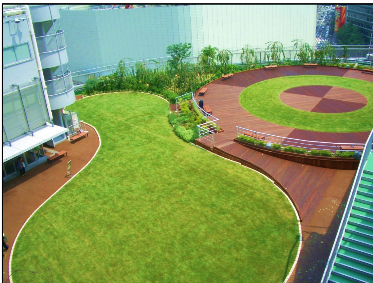
Figura 3: Telhado Verde com grama esmeralda.
